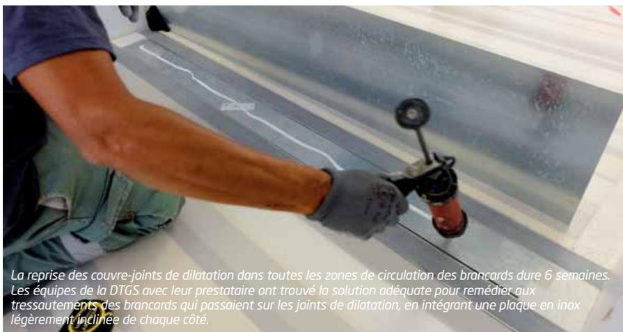
La reprise des couvre-joints de dilatation dans toutes les zones de circulation des brancards dure 6 semaines. Les équipes de la DTGS avec leur prestataire ont trouvé la solution adéquate pour remédier aux tressautements des brancards qui passaient sur les joints de dilatation, en intégrant une plaque en inox légèrement inclinée de chaque côté.
